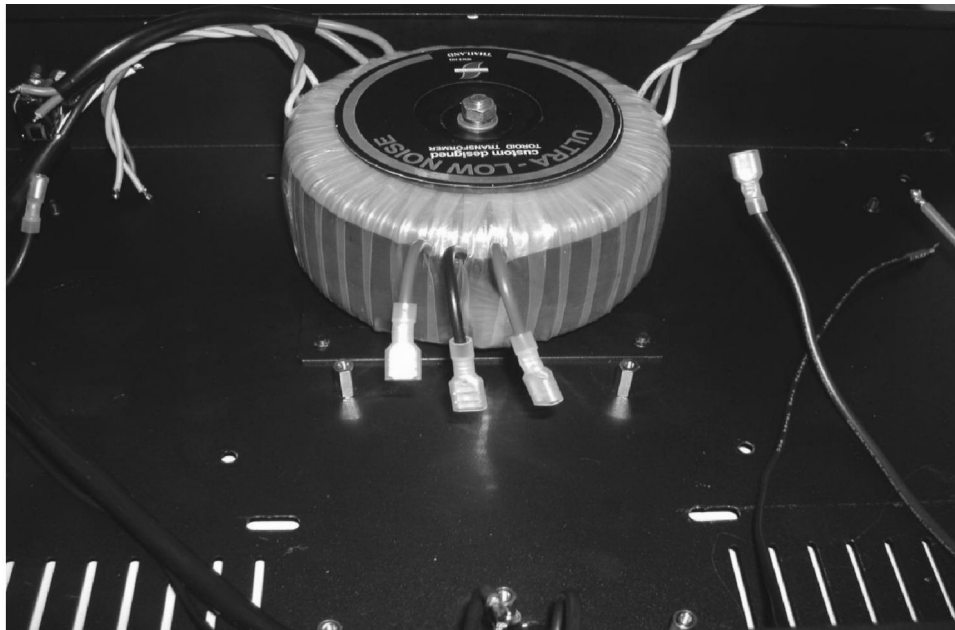
รูปที่ 34 การติดตั้งหม้อแปลง
