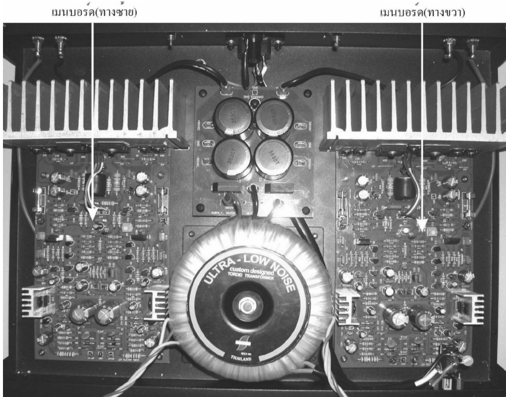
รูปที่ 39 การติดตั้งเมนบอร์ด
